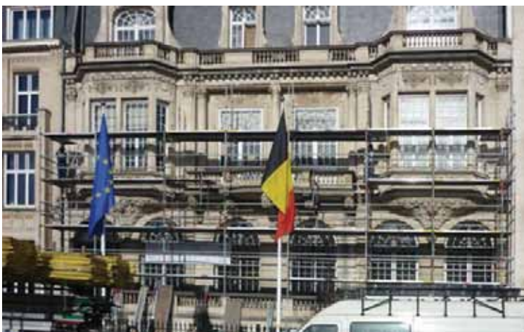
De gevel van Delen - Private Bank - Brussel met stellingen in januari 2011
